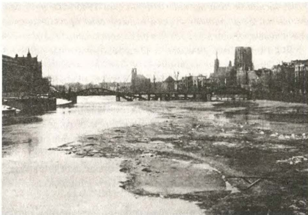
Восстановленный инженерной ротой Кайзеровский мост
