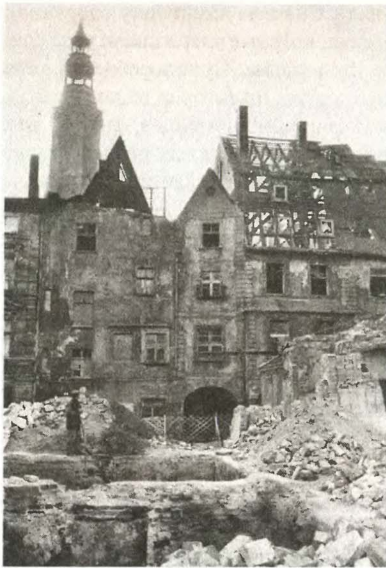
Башня ратуши, высящаяся над развалинами дома
