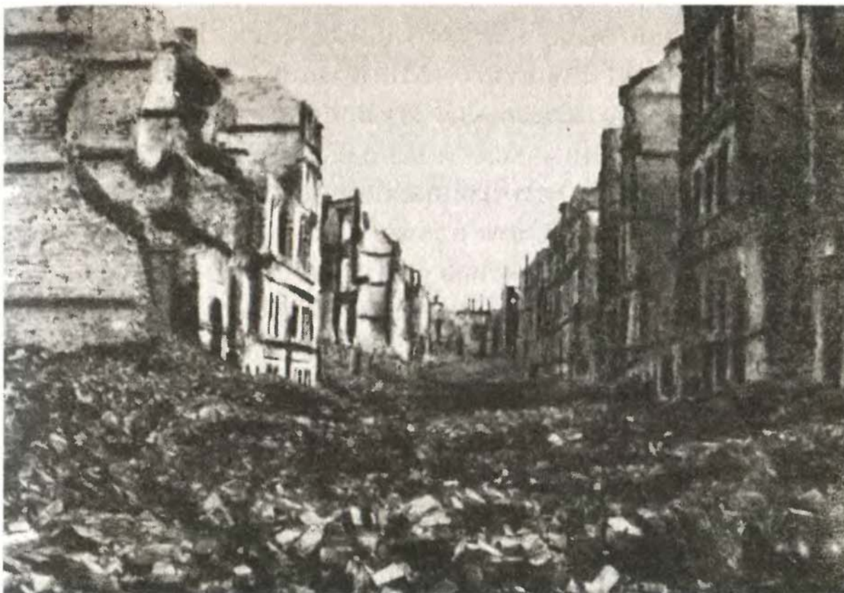
Полностью разрушенная во время артиллерийского обстрела Хильдебранд-штрассе
